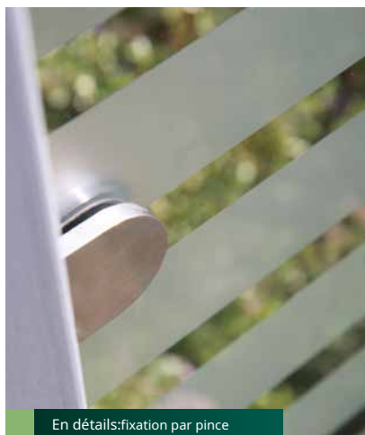
En détails: fixation par pince
